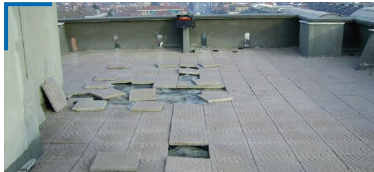
Mancanza di spessori necessari per posare una guaina bituminosa con soprastante massetto cementizio
